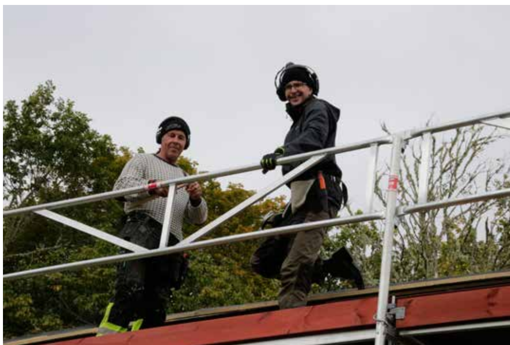
Per Byström och "Målar-Jonas" byter tak på Bachsalen. Den gamla byggnaden får ett fint tak av lertegel.
