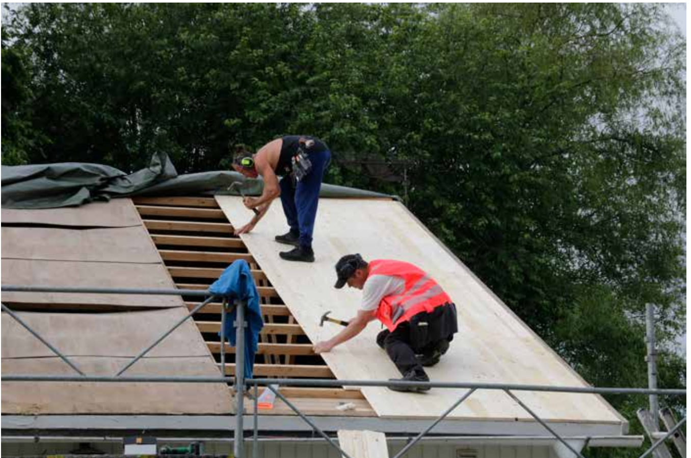
Fastighetsskötarna från, vänster Per Byström och Robert Lunde, spikar tak.
