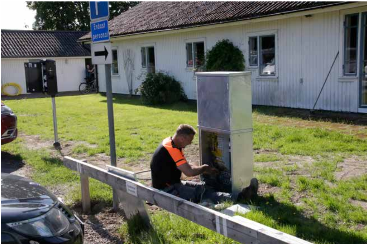
Stefan Nordström installerar laddstolpar.
